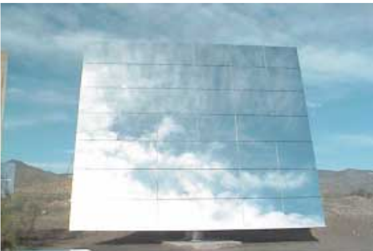
Figura 10. Vista frontal del helióstato Inabensa-Colón 70. Como se aprecia la optimización realizada por CIEMAT para el máximo aprovechamiento del campo disponible dio lugar a una disposición compacta de los espejos eliminando el típico hueco central para abatimiento
